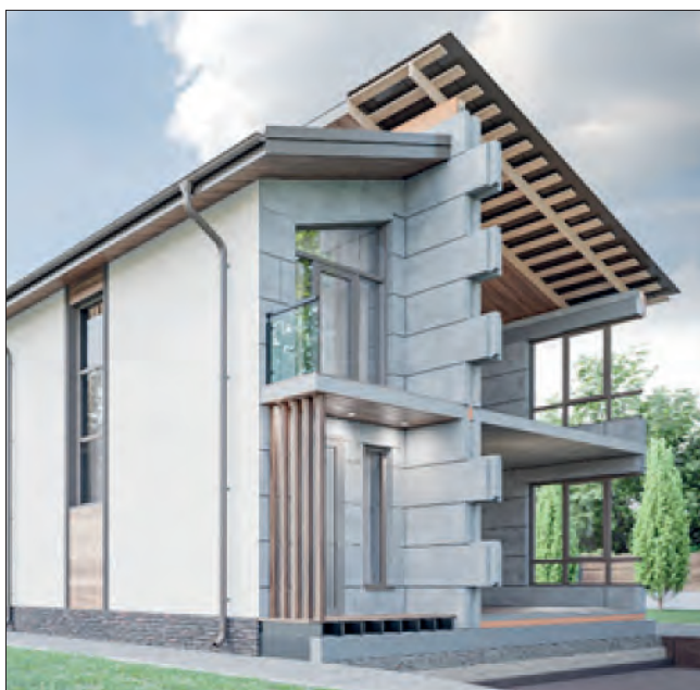
Рис. 6. Технология возведения жилого дома Fig. 6. Construction technology of a residential building
