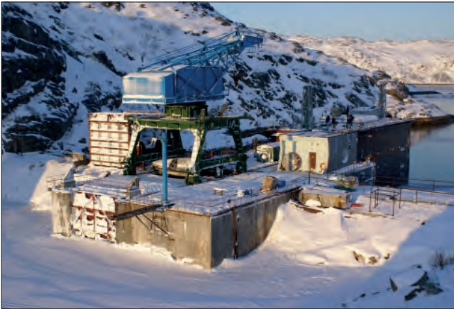
Рис. 1. Общий вид ПЭС со стороны бассейна Fig. 1. General view of the TPS from the pool side
