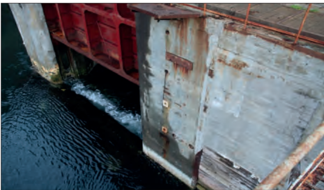
Рис. 2. Стенка со стороны бассейна. Повреждение бетона отсутствует Fig. 2. The wall on the side of the pool. There is no concrete damage
