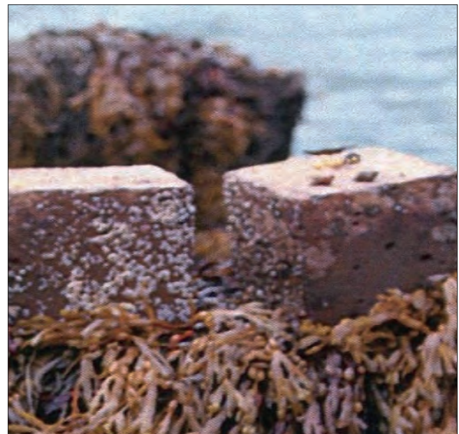
Рис. 5. Образцы из бетона с модификатором на морском стенде Кислогубской ПЭС после 13000 циклов замораживания и оттаивания Fig. 5. Samples of concrete with a modifier at the offshore stand of the Kislogubskaya TPS after 13,000 cycles of freezing and thawing
