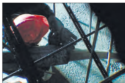
Рис. 4. Укладка самоуплотняющегося бетона класса В50 в густоармированную конструкцию фундаментной плиты высотой 4 м, объемом 14,2 тыс. м 3 с расходом арматуры 270 кг/м 3 башни «Восток» МК Федерация
