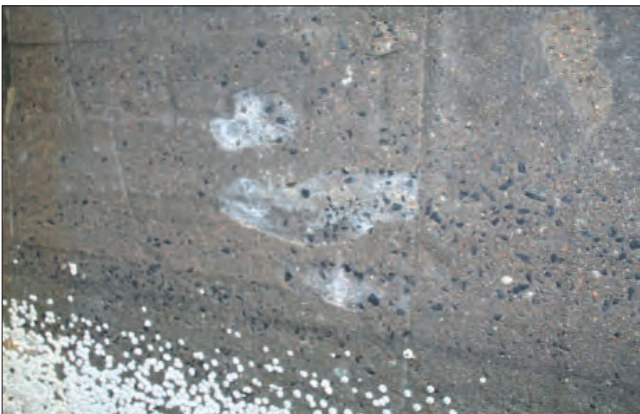
Рис. 3. Локальное шелушение цементной пленки на стенке ПЭС, на нижней части снимка – обрастание ракушкой – баянусом. Такое обрастание существенного повреждения бетона не вызывает Fig. 3. Local peeling of the cement film on the wall of the TPS, on the lower part of the picture – fouling with a shell – balanus. Such fouling does not cause significant damage to concrete
